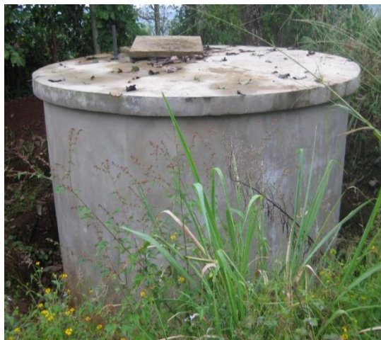
Cliché Noufin, 2016 Photo 4: Château d'eau de l'adduction de Tounang-Toula
