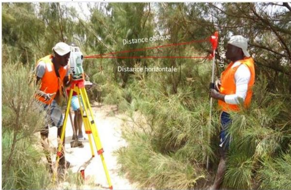
Photo 3. Mesure topographique avec la station totale
