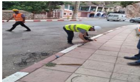
Figure 16. Installation des géophones reliés au sismographe
